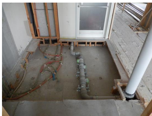
写真3 水廻りの配管工事
