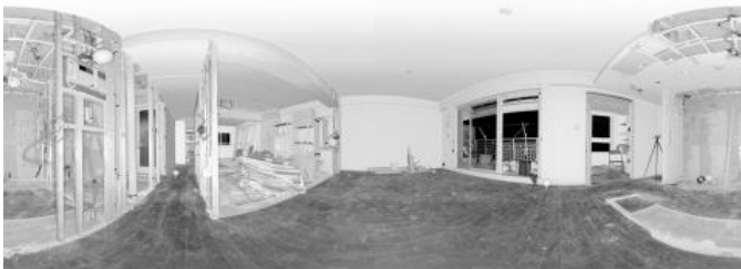
3次元レーザースキャナーによる測定結果をもとにCADデータを作成
