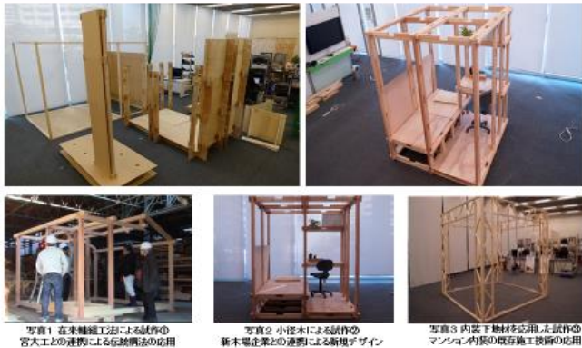
写真1 在来軸組工法による試作の 宮大工との連携による伝統構法の応用
