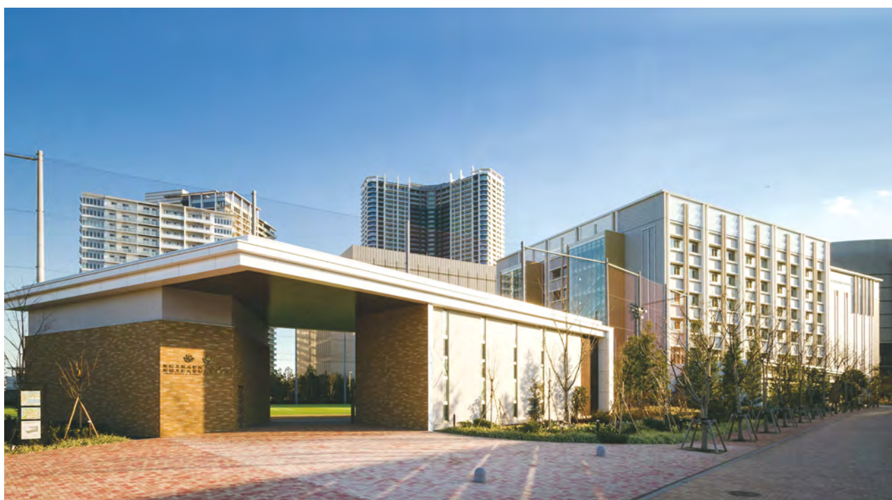
板橋校舎の1.5倍の敷地面積を有する新豊洲校舎
