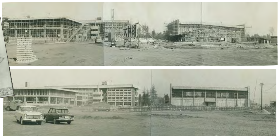
大宮キャンパス建設工事（上）と完成時（下）
