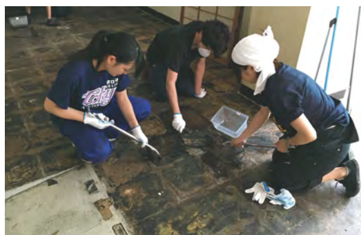
空き家改修プロジェクト
